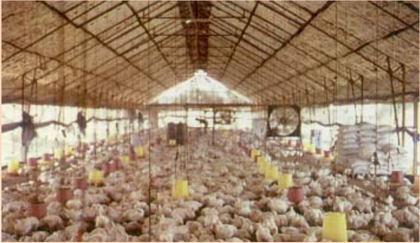
โรงเรือนมีฉนวนใต้หลังคา หรือมีฝ้า วัสดุอาจเป็นโฟม จาก หรือแผ่น ช่วยลดความร้อนจากหลังคาลงได้บ้าง
